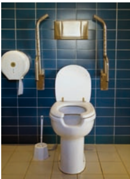
Un elevador del inodoro con apoyabrazos abatibles facilita la transferencia al mismo.
