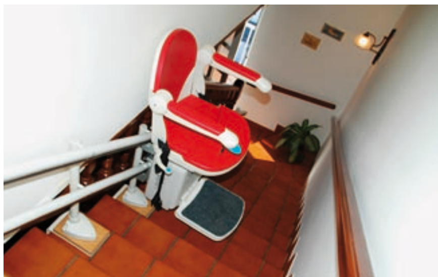
Elevador para salvar escaleras.
