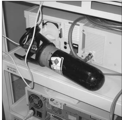
Riesgo de accidente de trabajo por caída de botella de gas no sujeta adecuadamente
