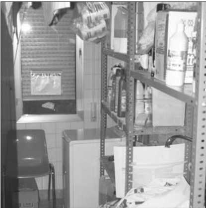
Riesgo de accidente de trabajo por caída de objetos desprendidos, por almacenamiento inadecuado, por falta de sujeción de las estanterías
